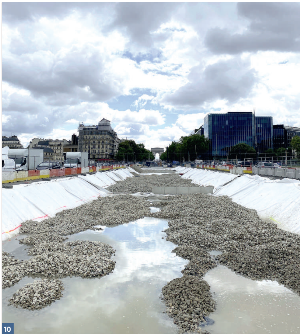
10. L'ensemble de l'aménagement a été raisonné pour optimiser l'infiltration sur place des eaux de ruissellement, selon le principe établi par la Ville de Paris, ParisPluie. EMPREINTE BUREAU DE PAYSAGES
