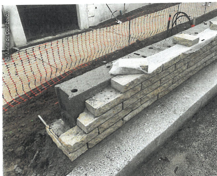
Des modules en pierres reconstituées couvrent des murets en moellons entre la chaussée et des noues végétalisées. Aperçu des cheminements en béton désactivé qui ondulent d'un côté de la rue, ici en cours de construction.
