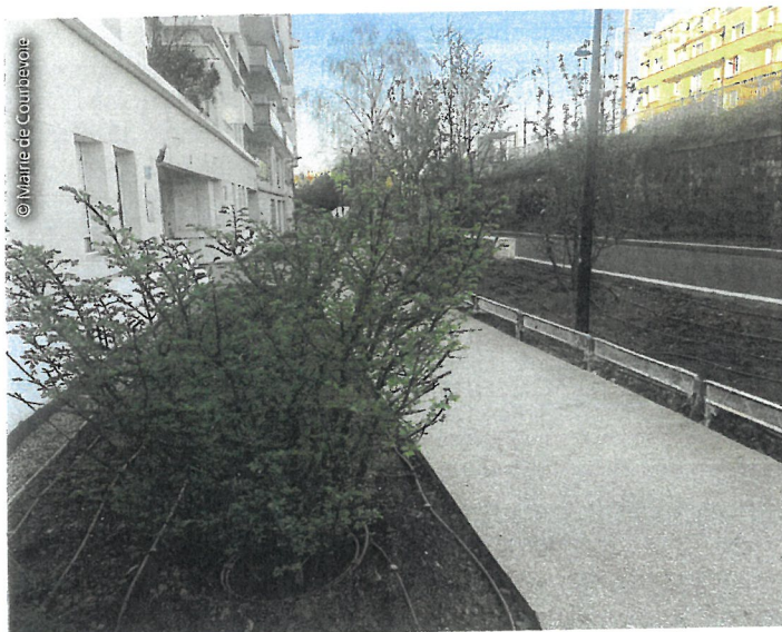
Plus de 100 m 3 de terre végétale ont servi à la réalisation des zones de plantation. Toutes sont irriguées par des lignes de goutteurs, certaines enroulant le pied des arbres et arbustes en surface.
