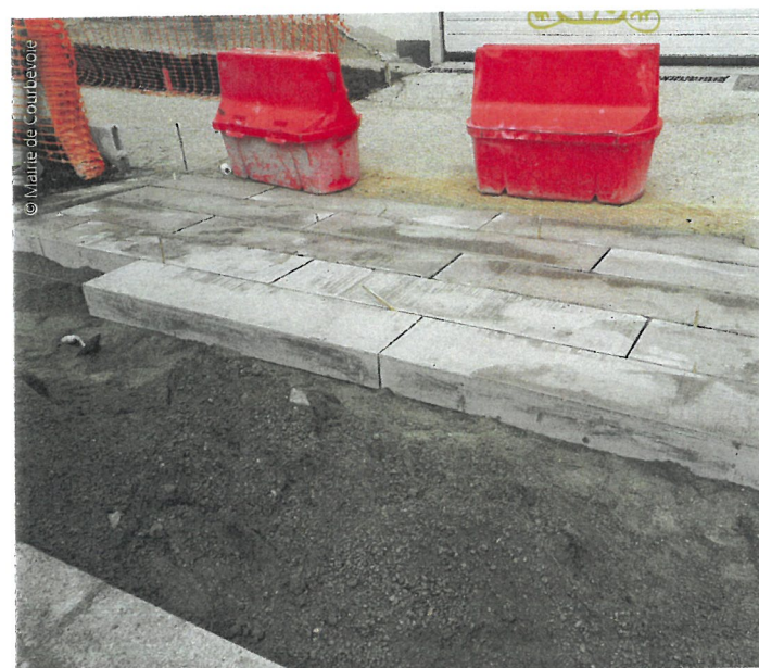
Au niveau des entrées charretières, des modules d'1,5 m de long en béton matricé symbolisent les traversées.
